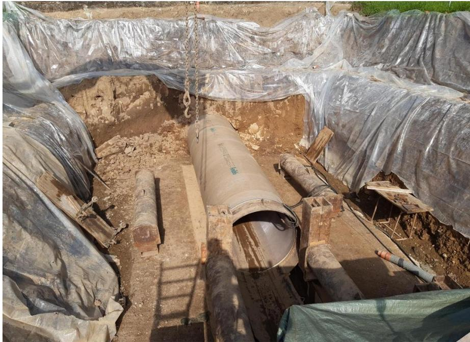
**Figura 6. Attrezzatura di spinta del collettore (visibili i martinetti, l'anello di ripartizione e la tubazione in PRFV).**
