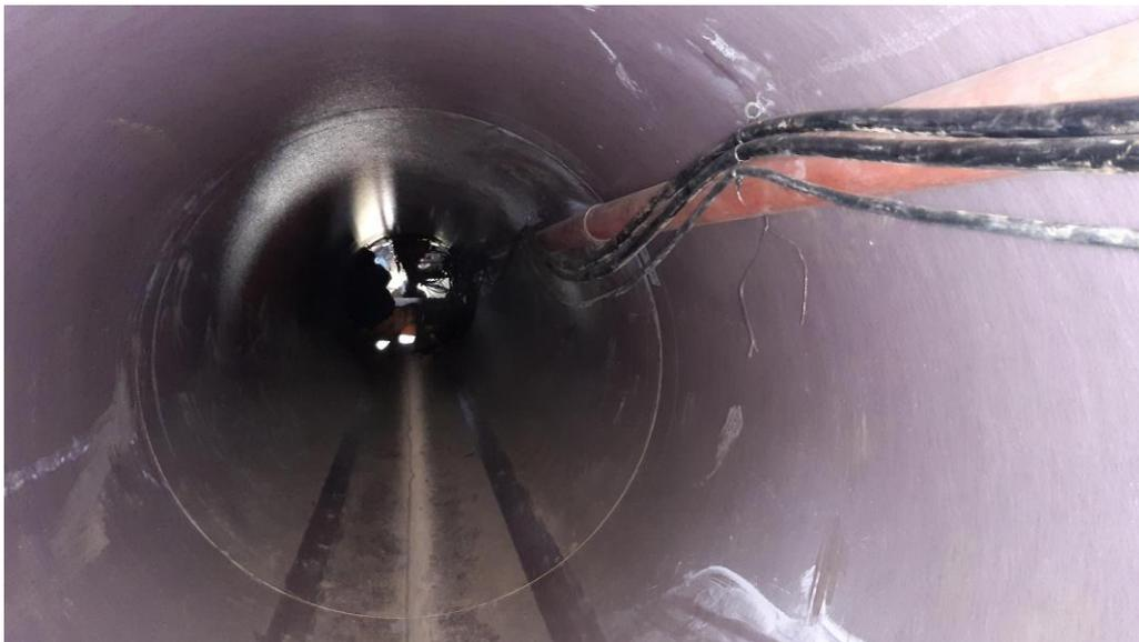
**Figura 7. Operatore in fase di asportazione del materiale compenetrato tramite spinta.**
